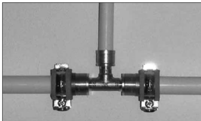
Wykonanie punktu stałego na trójniku
