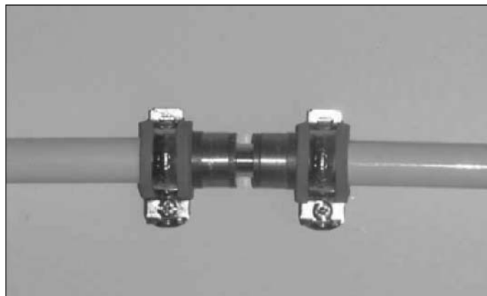
Wykonanie punktu stałego na dwuzłączce prostej
