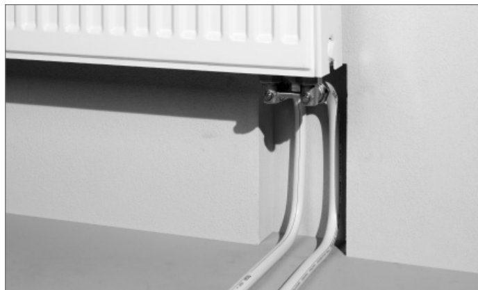
Podłączanie grzejnika ze ściany
