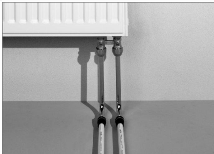
Podłączanie grzejnika za pomocą kolanka montażowego HK
